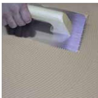
Aplicar el adhesivo con una lana dentada, sobre la anterior capa del producto.
