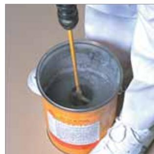
En el caso de mezclado de productos de dos componentes: extraer los componentes A y B, verterlos en el recipiente apropiado y agitar. Seguidamente verter la mezcla en el Componente C y homogeneizar la mezcla.
