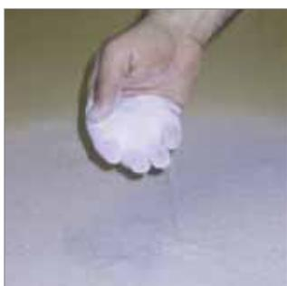
Si va a colocar un revestimiento posterior con morteros-cola, se debe espolvorear arena, en fresco, para crear anclaje.
