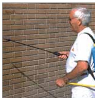
Si se desea se puede hacer una aplicación de manera mecánica (con una sulfatadora p.ej.)
