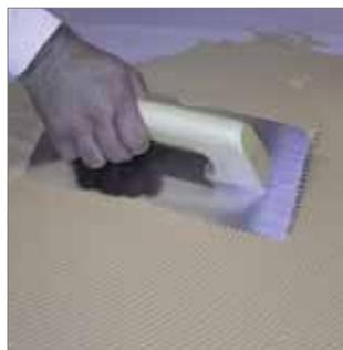
Dar una segunda capa, con la parte dentada de la llana, en dirección perpendicular a la primera.
